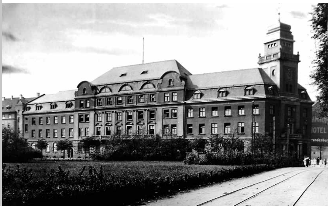
Neubau Postamt, Architekten Postbaurat Sell und Neufeld (Bauleiter), Fotografie um 1920.
